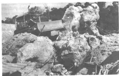
Lubang-lubang yang merbahayakan terpaksa dikambus
