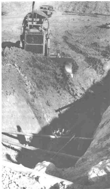
Kerajaan mengambil langkah menimbus lubang-lubang yang dianggap berbahaya
